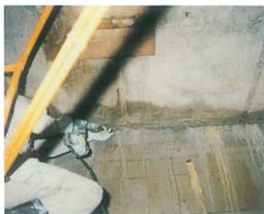
Vカット部水洗い
